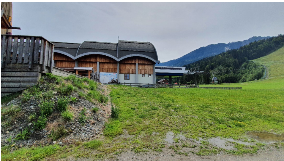
Liegenschaft | Talstation Tröpolach, 9620 Hermagor
