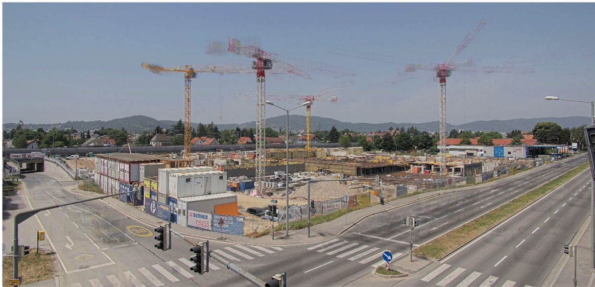
Baustellenfoto 20.06.2021 | Triester Straße 432, 8055 Graz
