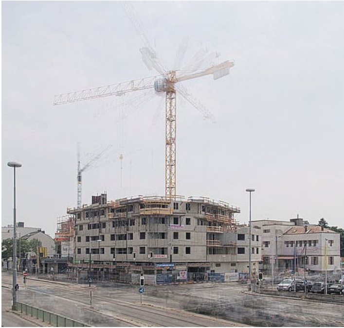
Baustellenfoto 20.06.2021 | Genochplatz 1, 1220 Wien
