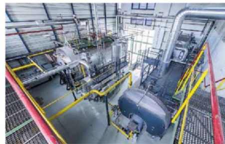
Beispiele für Abwärmenutzung in Österreich. Oben: Zellstofffabrik Pöls | Unten: Brauquartier Graz Puntigam
