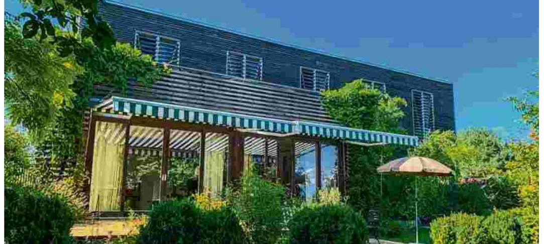
Diese Architektvilla in Attersee am Attersee bietet alle Annehmlichkeiten in einer hervorragenden Lage. Foto: Zeit am See Immobilien
