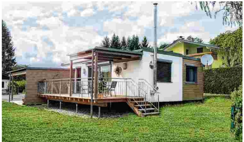
Das Haus steht auf Schraubfundamenten. Das Grundstück wird nicht angetastet.
