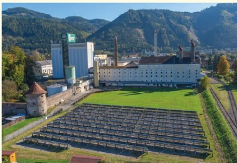
In der Brauerei Göss arbeitet man schon seit 2013 mit Solaranlagen.
