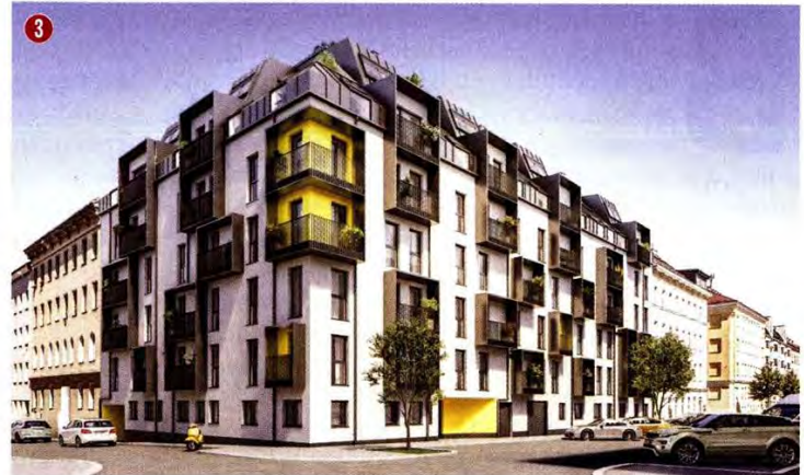
Das Projekt „Lemonie“ wird von 3SI in der Ottakringer Albrechtskreithgasse gebaut und ist fast ausverkauft. Die Fertigstellung erfolgt nächstes Jahr.
