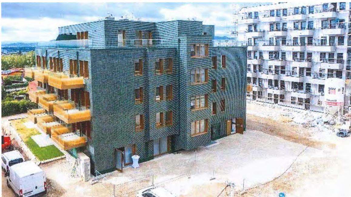
Baustellenfoto 2023 | Laxenburger Straße 151, 1110 Wien
