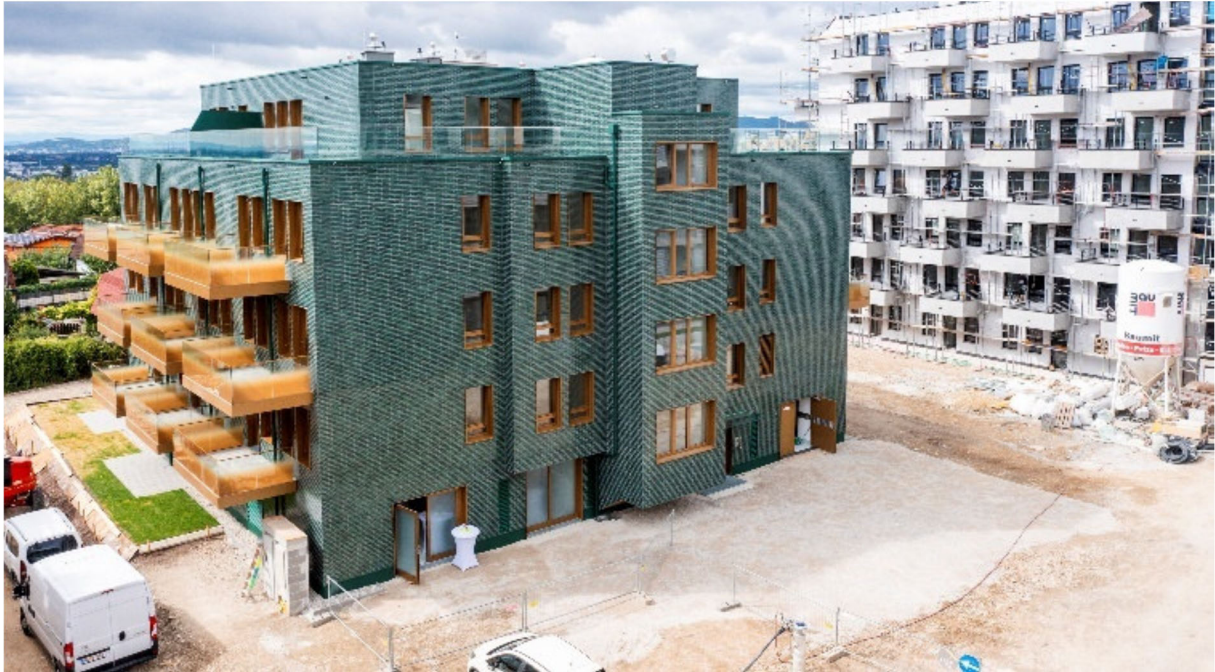
Baustellenfoto 2023 | Laxenburger Straße 151, 1110 Wien
