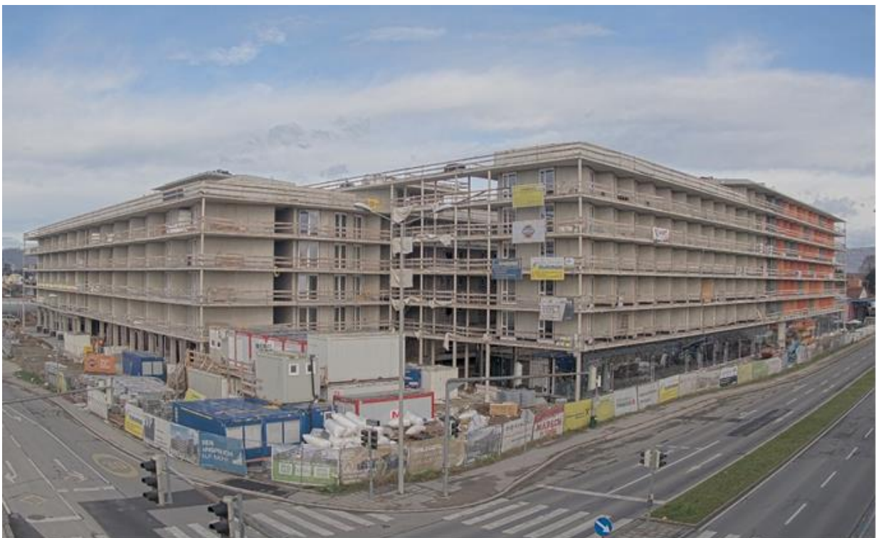
Baustellenfoto 31.03.2023 | Triester Straße 432, 8055 Graz
